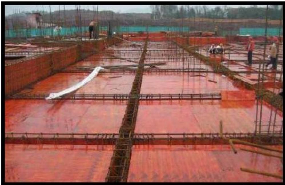
梁筋綁扎後的井字梁板模安裝外觀
