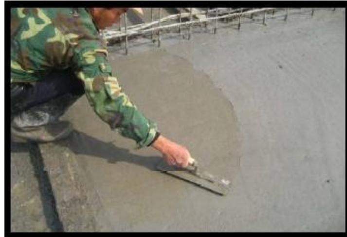
屋面、地下室顶板或无装修层地面采用收光机做收光（不少于2次）。地面有二次装修时，做拉毛处理，磨光机收面完成后进行拉毛处理
