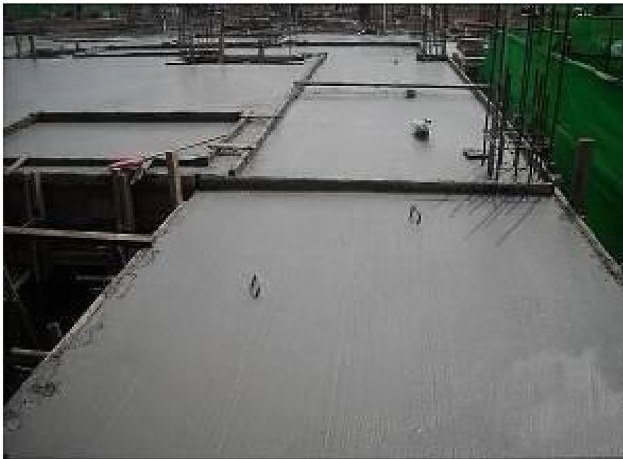
混凝土浇筑完成后，楼板达到1.2 MPa后才允许上人(12小时左右，行走不留脚印)，
