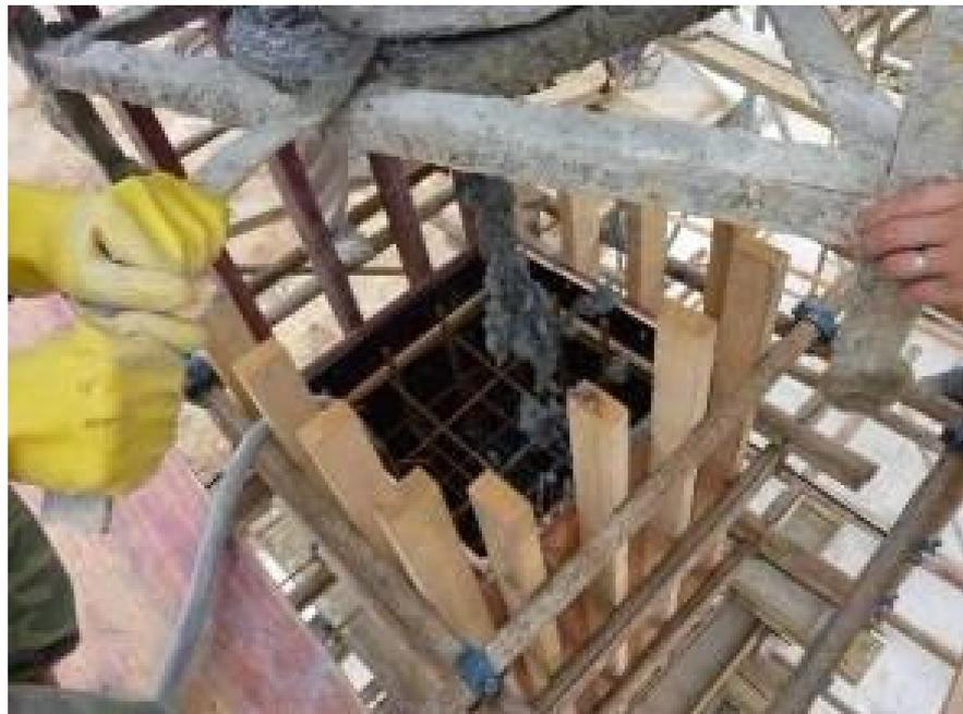
混凝土墙柱浇筑时，采用振捣棒和人工配合，人工从下往上采用人工辅助敲击模板，锤击间距200mm，边浇筑边锤击，有效控制表面气泡、蜂窝、麻面产生
