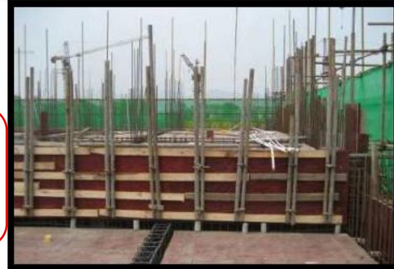
高低跨吊模位置，采用(土)字型钢筋支撑架支撑上部模板，禁止钢管直接支撑在下部板面上，禁止采用混凝土撑块。
