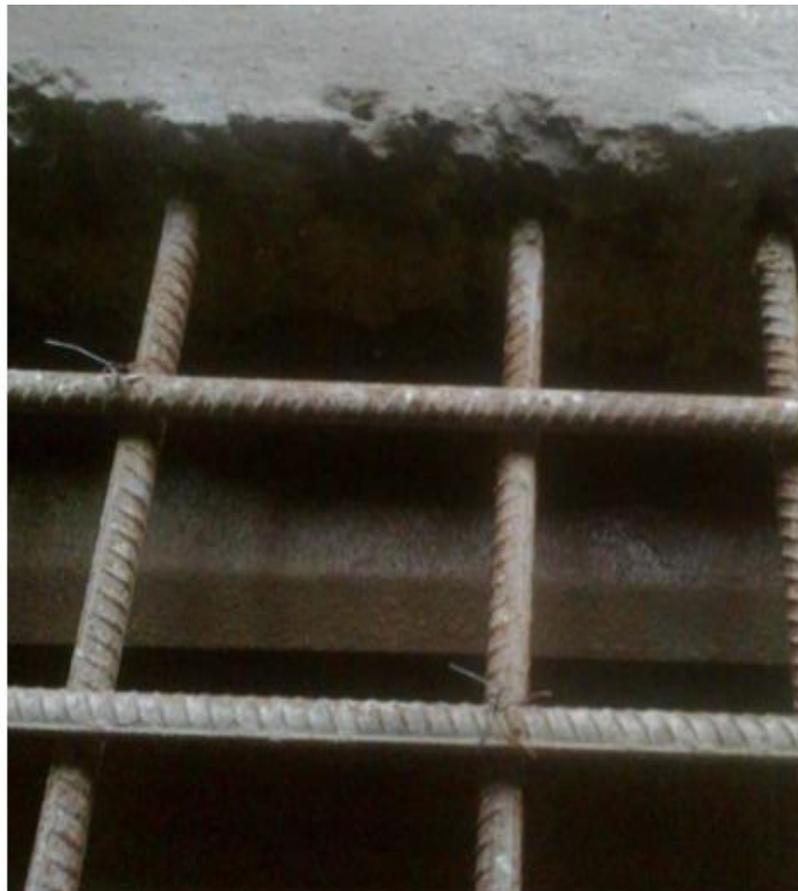
底板后浇带浇筑前新旧混凝土交界部位应剔凿、清理干净
