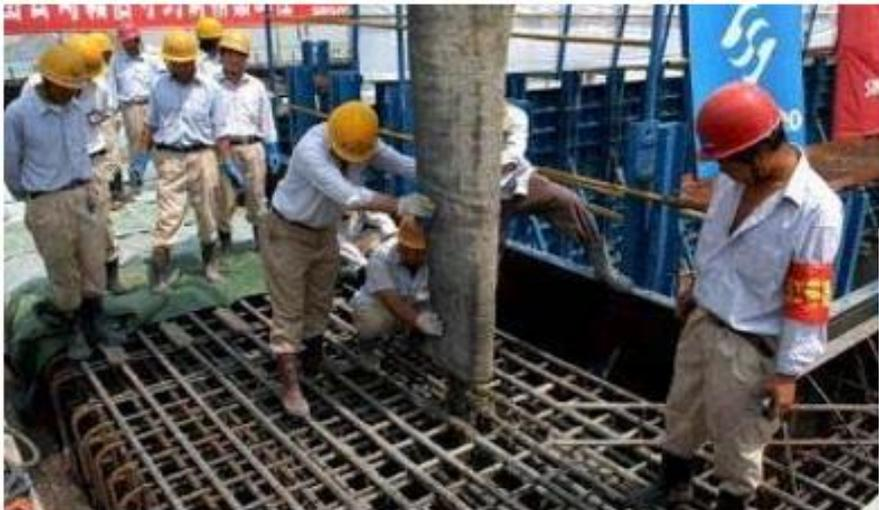
混凝土浇筑时应派专人观察模板、钢筋、预留洞口、预埋件、插筋等有无位移变形堵塞等情况,发现问题应立即修改并应在已浇筑的混凝土初凝前修整完毕。
