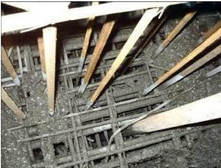
梁柱交接处钢筋过密时，绑扎时应留置振捣孔。
