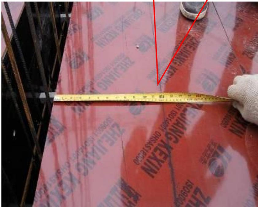
梁板模板安装完成后，首先采用拉线检测模板极差，还应用铝合金尺进行板面平整度检测。模板间缝隙不得大于1mm，大于的缝隙用胶带进行张贴。
