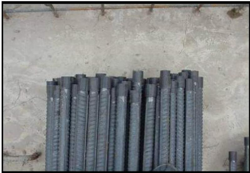
加工完毕的钢筋丝头戴好保护帽或部分连接套筒，防止碰撞损坏丝头。
