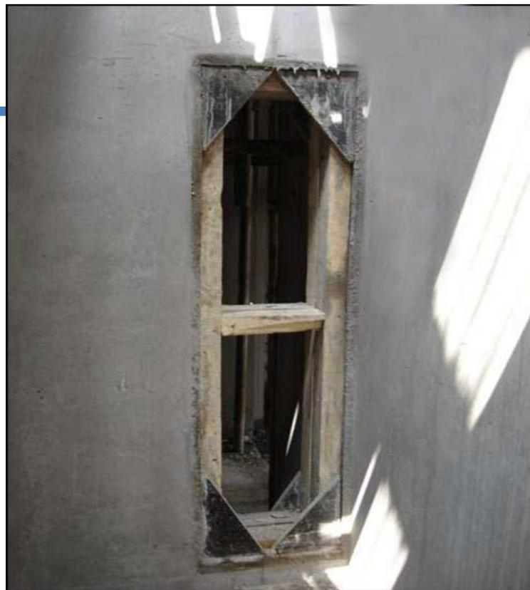
吊模撑块必须采用不低于浇筑混凝土标号的成品撑块，禁止使用木枋、模板条。采用木枋、模板制作吊模，必须严格控制模板截面尺寸，阴阳角采用三角板加固。
