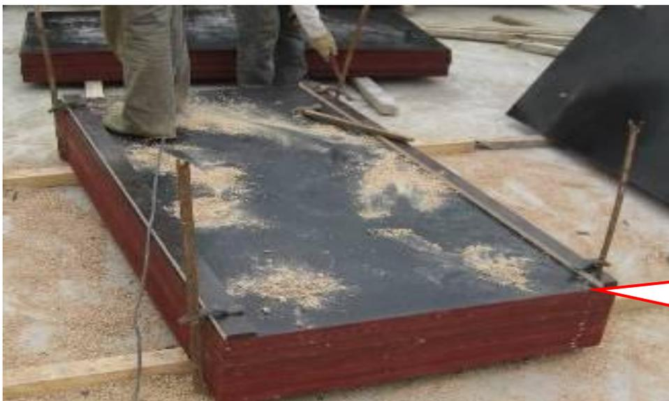
所有模板支撑架位于土质上需要设置跳板，位于混凝土板面上需要设置（木枋、模板）垫块。模板必须按照设计要求进行起拱（千分之一至千分之三）
