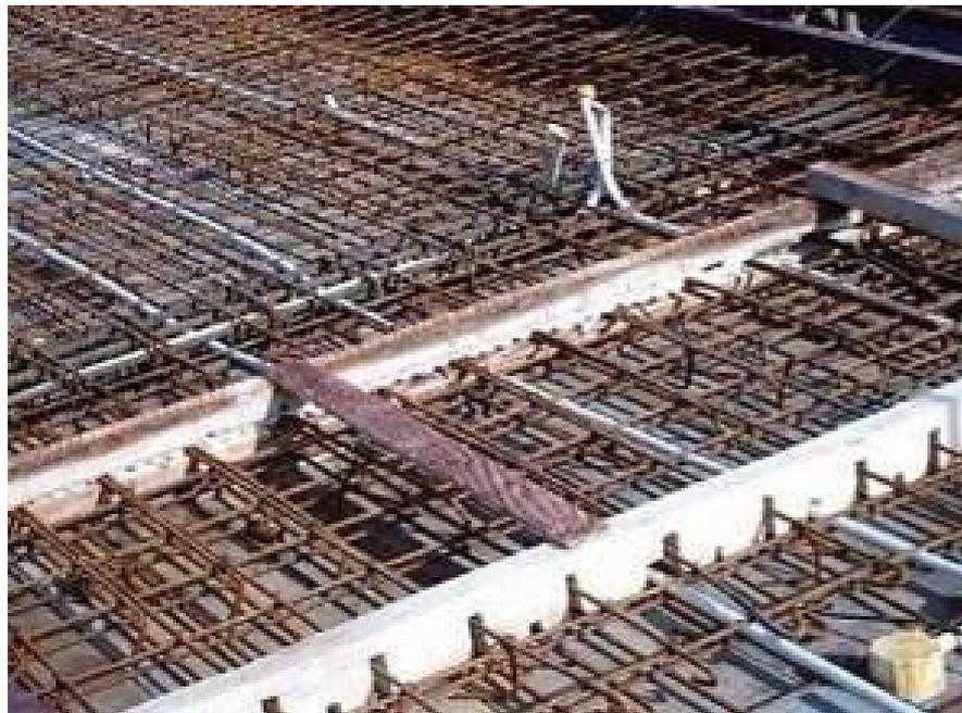
楼板后浇带采用模板做锯齿形（支撑条控制小于500mm）
