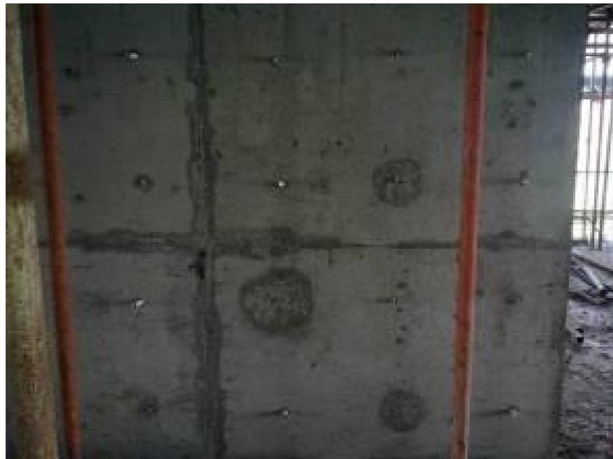
模板表面严禁出现无用的孔洞（模板多余螺杆洞未封堵，混凝土浇筑时孔洞漏浆造成墙体表面观感质量差），需要采用成品堵头封堵后使用
