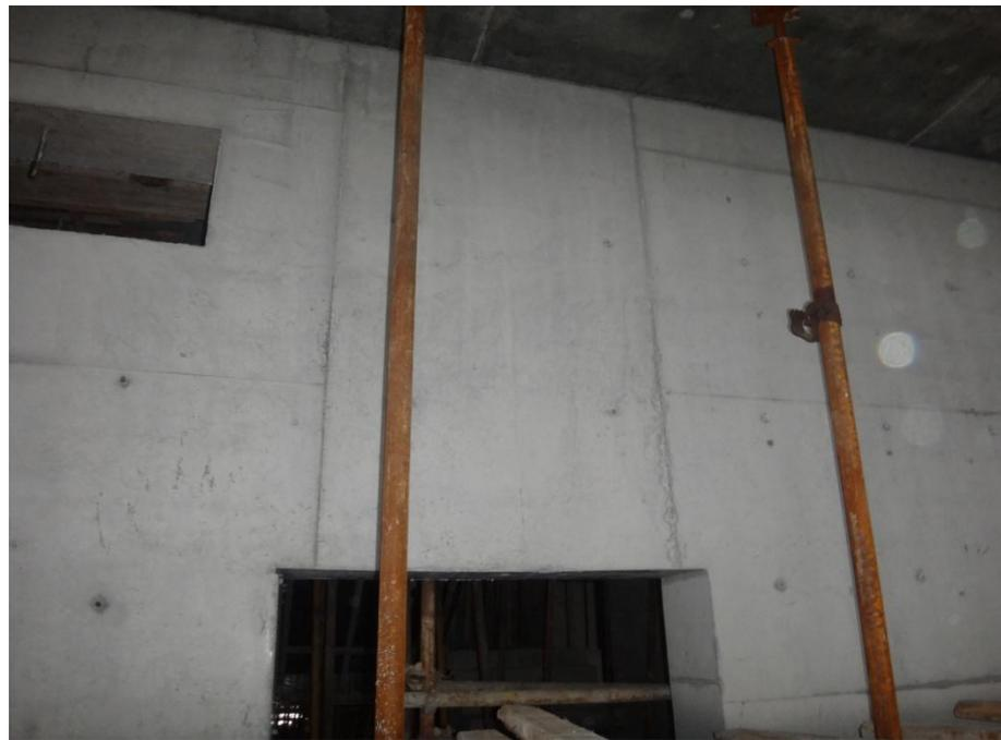
剪力墙连梁处水平加固钢管必须通长设置，与剪力墙连成整体，保证墙体与连梁接缝平整。
