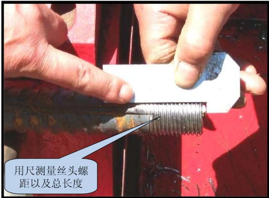
用尺测量丝头螺距以及总长度
