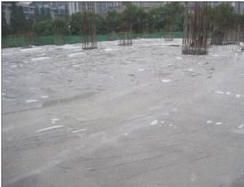
雨季施工，浇筑后采用塑料薄膜或三彩布遮盖
