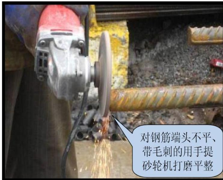
对钢筋端头不平、带毛刺的用手提砂轮机打磨平整
