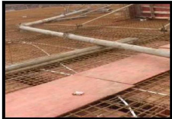
泵管接头下放置塑料布防止漏浆
