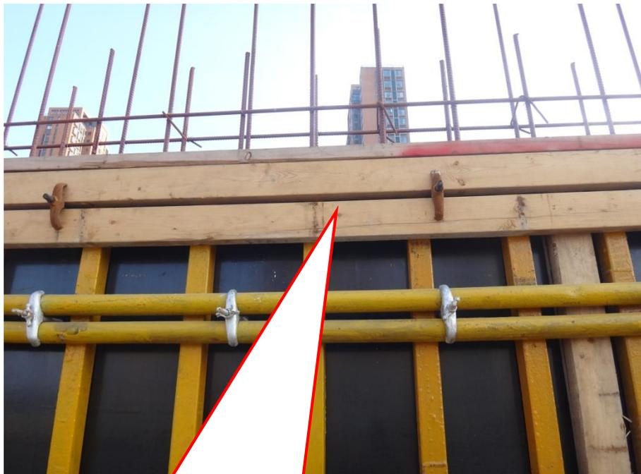
在外剪力墙支模时，所有加固方木应与模板上口平齐，再在上口处结合预埋螺栓设置通长方木，用来固定上口模板，防止变形，保证墙体混凝土外边平直度。
