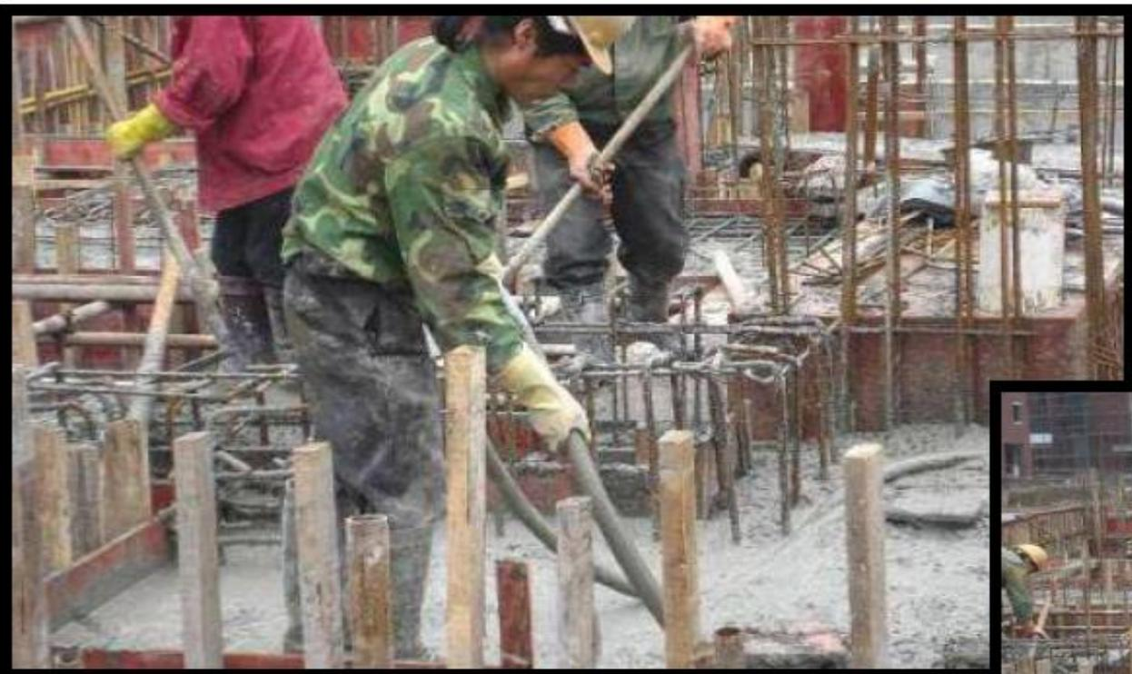
振动棒插入点距50cm左右，振捣时间不少于15秒；快插慢拔，排出砼内气泡。
