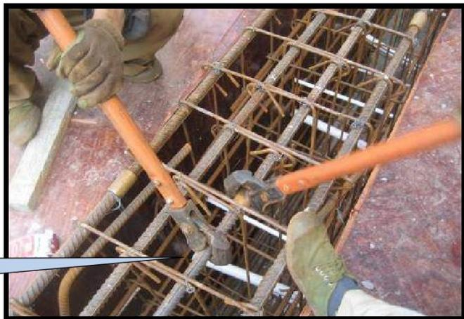
用工作扳手拧紧钢筋直螺纹连接接头
