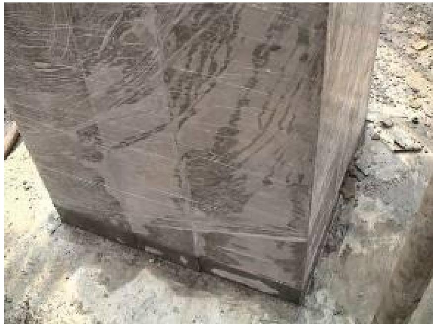
柱墙采用薄膜包裹养护， $\pm 0.000$ 标高以上养护时间为7天； $\pm 0.000$ 标高以下（以及添加外加剂部分）养护时间为14天；
