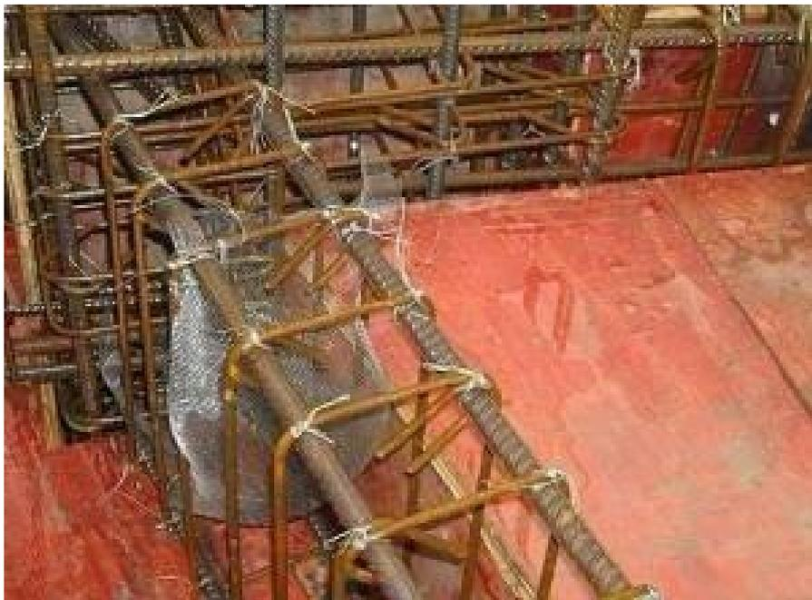
柱砼标号高于梁一个标号时，梁距柱边500mm处加设钢丝网（该区域混凝土标号砼墙柱）
