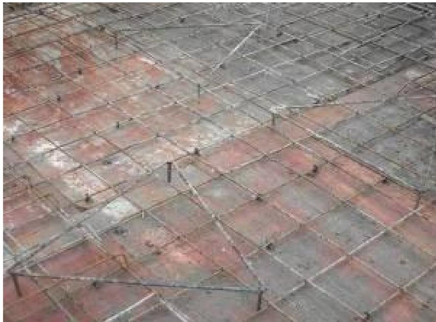
设置钢筋三角架，浇筑时配合刮尺使用，控制楼板厚度、平整度。在混凝土收平后可取出，间距 $\leq 1.8\text{m}$
