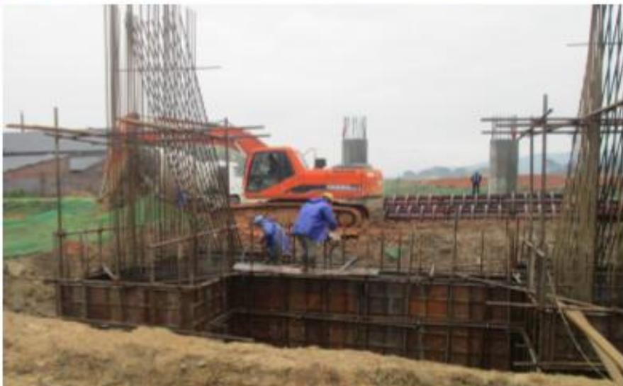
施工缝在继续浇筑混凝土前,应清理干净
