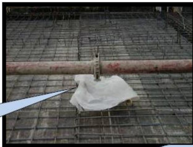
设置钢管支撑，防止输送砼时泵管自由晃动
