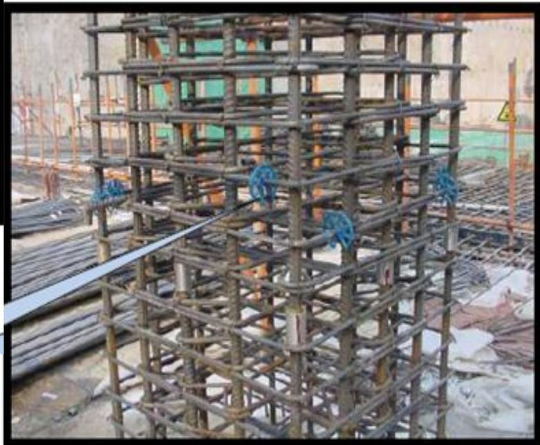
柱墙筋保护层用相应规格塑料垫块
