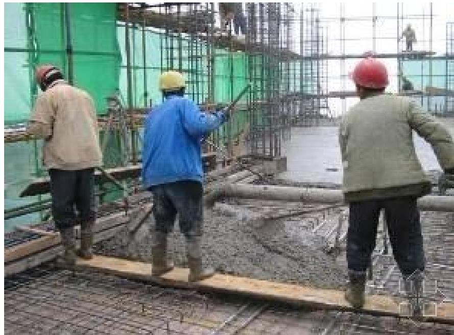
楼板浇筑前采用铁锹初步平整
