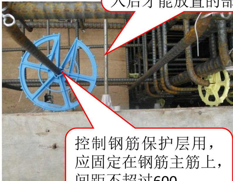
控制钢筋保护层用，应固定在钢筋主筋上，间距不超过600
