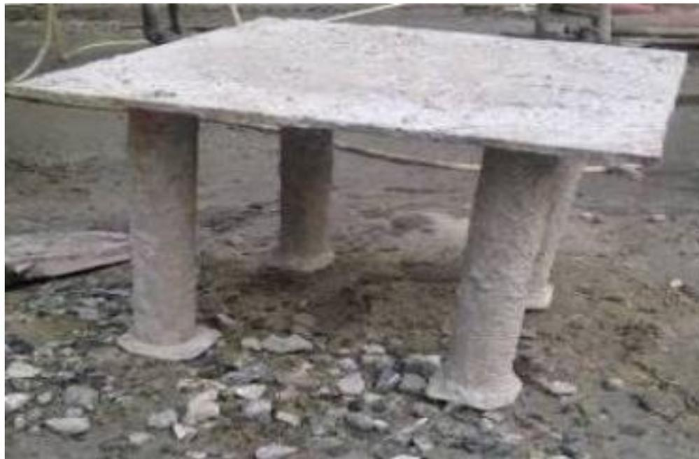
布料机下部必须设置独立支撑进行顶撑，禁止布料机直接受力在模板版面上。
