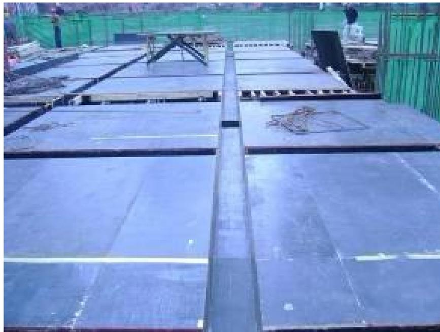
模板表面缝宽 $\geq 1.5\text{mm}$ ，采用胶带粘贴，避免漏浆，板面浇筑混凝土之前必须将板面垃圾，杂质的清理干净，并且板面需要浇水润湿。
