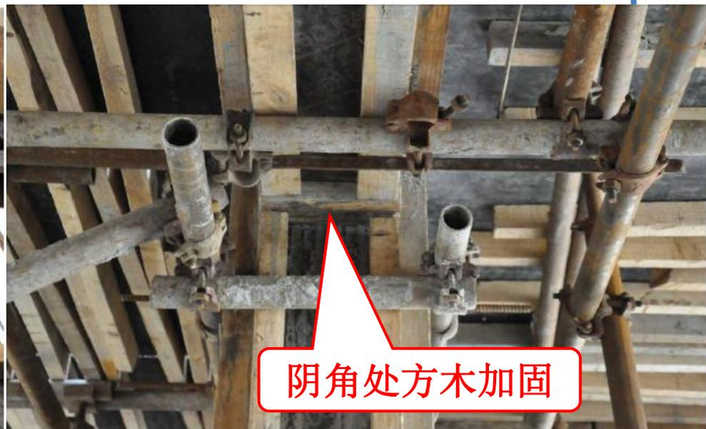
梁墙交接处，梁底模在墙堵头板上方，与堵头板内表面平齐，梁底方木距墙堵头不超过100，木方外挑横向支撑钢管长度不大于30cm，防止梁端头出现下坠现象。
