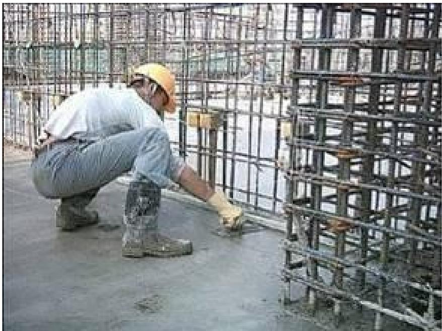
墙柱边混凝土收面标高、平整度控制在3mm以内
