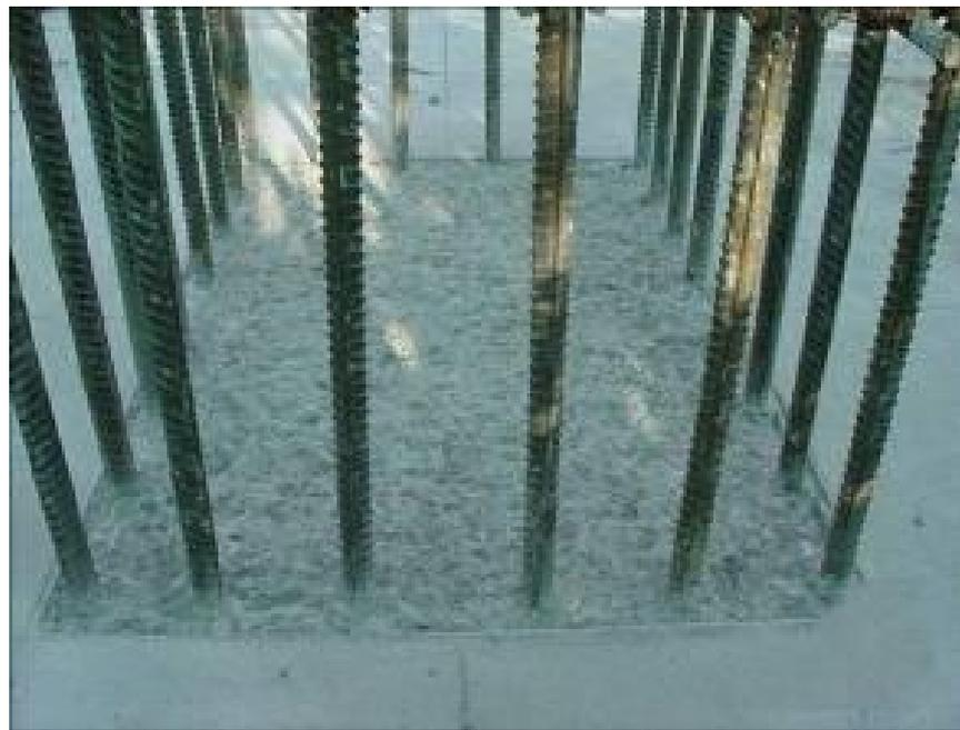
墙柱混凝土凿毛，表面凿毛面积 $\geq 70\%$
